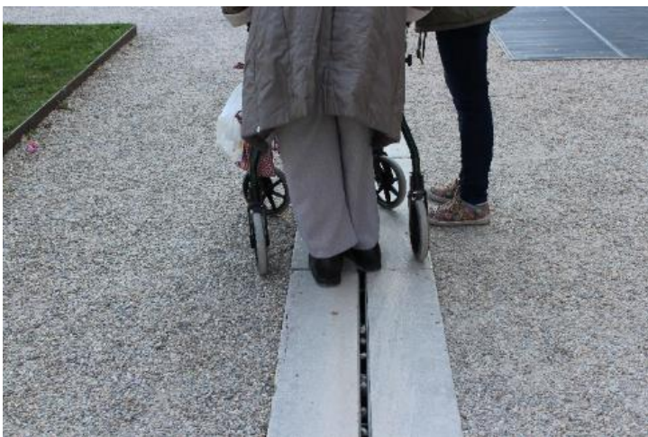
Abbildung 17: Befahren der betonierten Abwasserrinnen (Quelle: B-NK GmbH)
