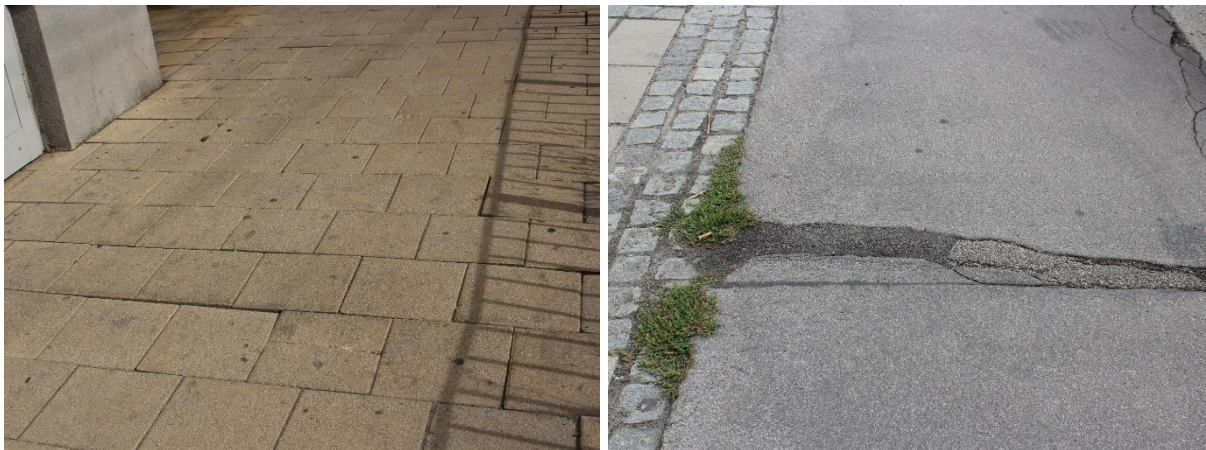
Abbildung 8: Unebener Plattenbelag und Beschädigung im Asphalt führen zu Stolperfallen (Quelle: B-NK GmbH)
